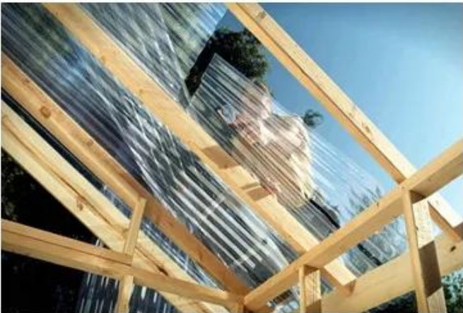
FRP 是一种由玻璃纤维和塑料制成的复合材料，具有强度高、重量轻、耐腐蚀、使用寿命长等优点。FRP 广泛应用于建筑、交通、工业等领域。FRP 是一种由玻璃纤维和塑料制成的复合材料，具有强度高、重量轻、耐腐蚀、使用寿命长等优点。FRP 广泛应用于建筑、交通、工业等领域。
