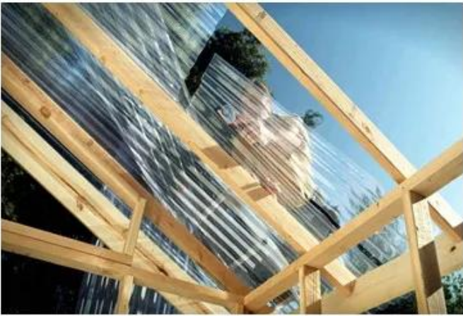
FRP 是 一種 輕便 耐用 且 易於 安裝 之 材料， 常用 於 建築 屋頂 及 圍牆。 其 優點 包括 重量 輕、 抗 腐蝕、 抗 風 及 抗 火。 在 本 圖 中， FRP 被 用 於 製 造 溫 室 之 屋頂 及 圍牆， 以 保 護 內 部 之 植 物。
